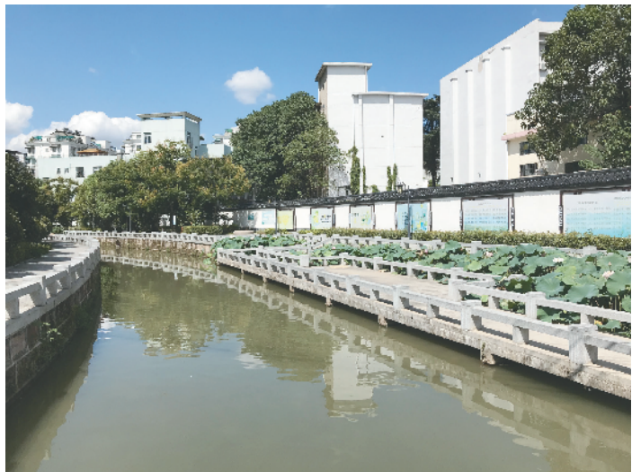
好溪堰 海潮村段
