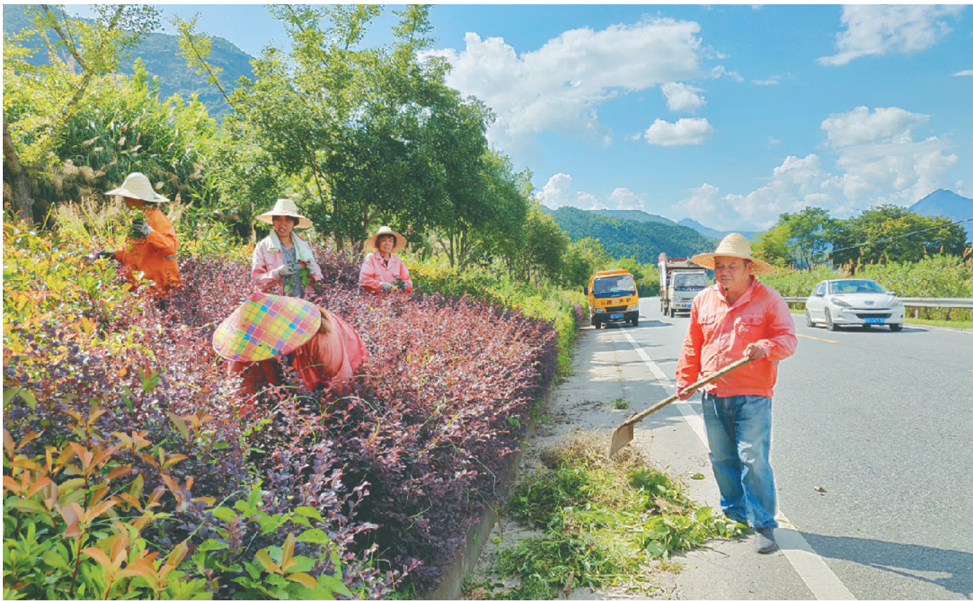
龙泉市公路管理部门对公路“病害”进行及时修补、对公路边沟及公路绿化杂草进行及时清理。
