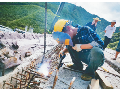
在龙庆高速公路庆元连接线，工人在烈日下施工。
