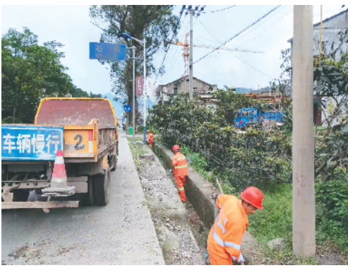
青田公路养护工人在疏通和维修公路水沟。
