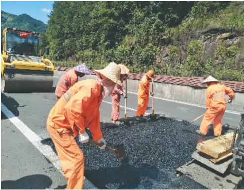
G330国道上，养护工人在高温下摊铺沥青。
