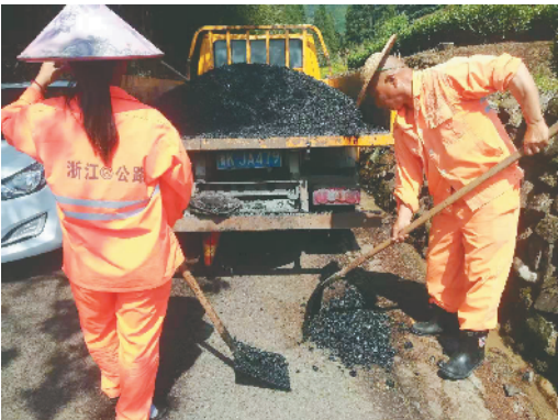
松阳养护人员对干线公路“病害”进行处置。
