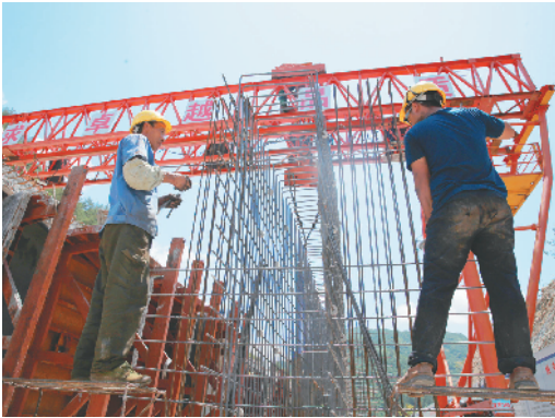
在缙云金谷至方溪道路建设工地，工人挥汗如雨。
