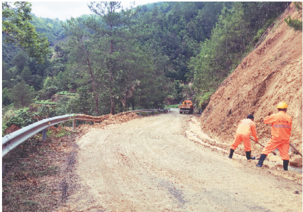
遂昌公路部门在老三际线K33+800清理作业。
