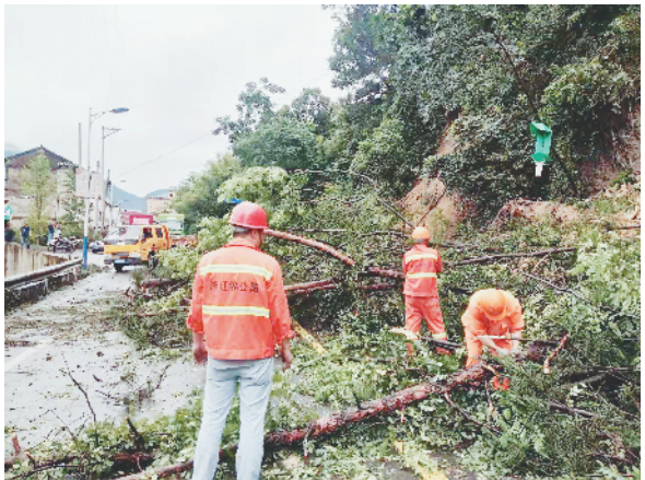
青田公路部门在333省道对翻倒在公路的树木进行清理。
