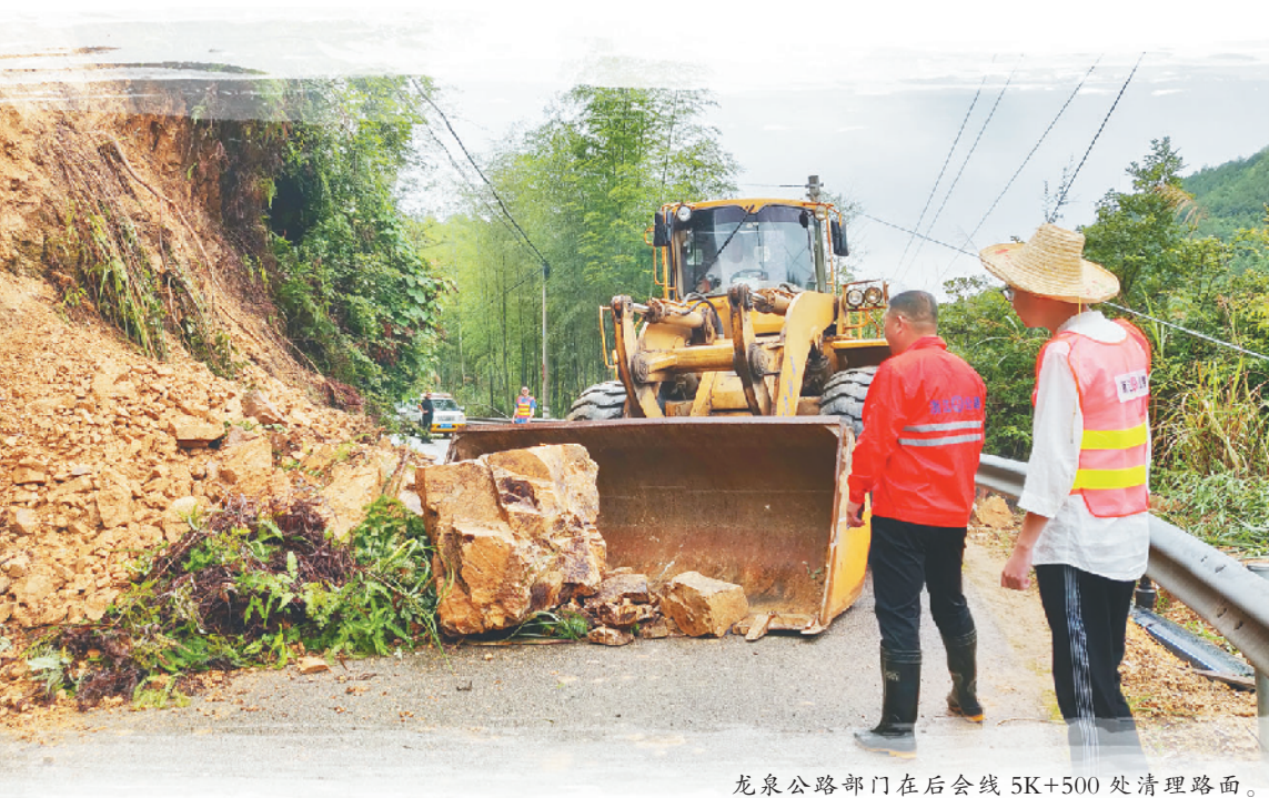
龙泉公路部门在后会线 5K+500 处清理路面。
