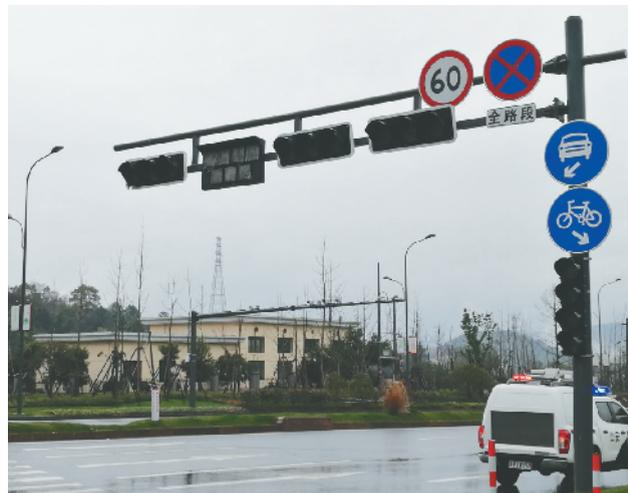
信号灯靠太阳能充电,春节以来持续多雨,导致光照不足、电量不够,所以出现了信号灯“罢工”的问题。
