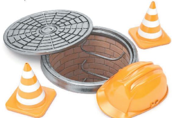
打开窨井盖施工,周围要加上防护设施和警告标志。
